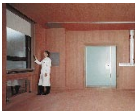
EEG-Untersuchungsraum im Städtischen Krankenhaus in Oostende/Belgien vor dem Innenausbau ...
