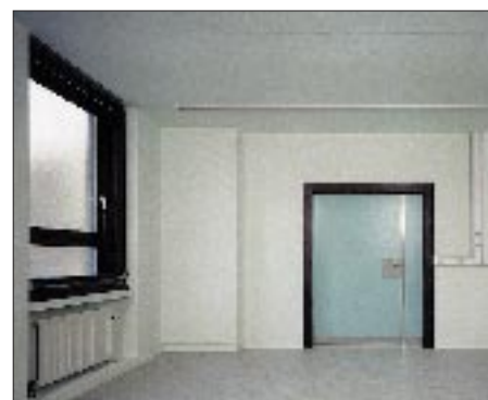
... und nach dem Innenausbau. Die Schirmung ist unter der Rohfaser-Übertapezierung nicht mehr sichtbar.
