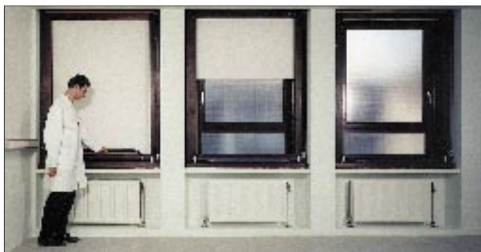
Fertig ausgebauter Datensicherheitsraum mit drei Shieldex-Rolls-Fenstern
